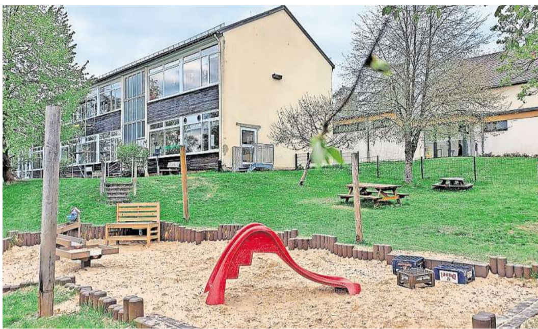
Die Grundschule Neuhaus soll saniert und den Anforderungen entsprechend baulich modernisiert werden. In dem Gebäude sind auch Kindergarten und Krippe untergebracht, rechts die Turnhalle, ebenfalls mit großem Sanierungsstau.
